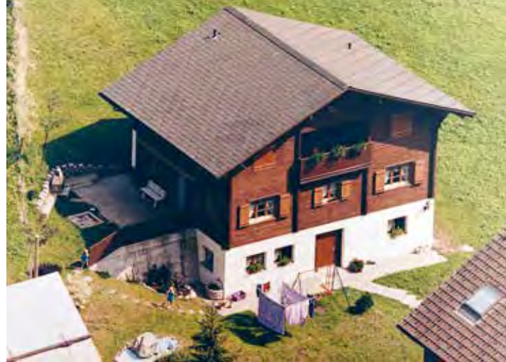
Inaccessibile. Fino a poco tempo fa, la casa di Martha Gasser era raggiungibile solo tramite una scalinata.
