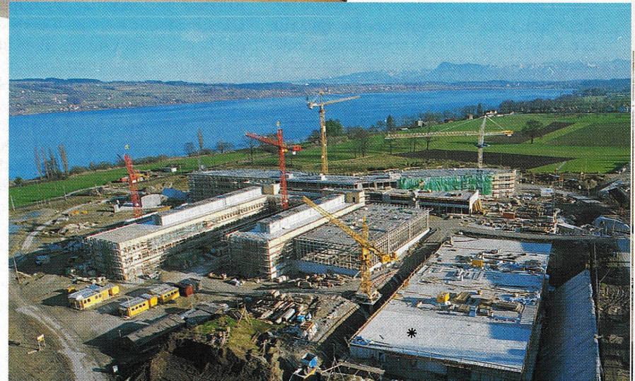
Die Übersichtsaufnahme zeigt die Grösse der Bau- stelle. Die Auto-Einstellhal- le (*) im Vordergrund ist in- zwischen wieder über- deckt.
