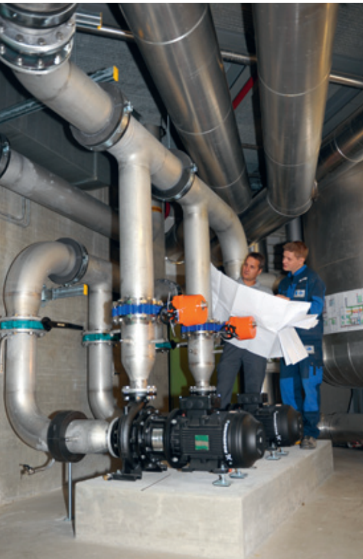
Ein Heizungsmonteur bespricht mit Meinrad Müller die Leitungsführung.
