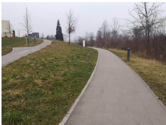
Abbildung 40: Bauliche Massnahme im Bereich S20 am Unterlauf des Eybaches
