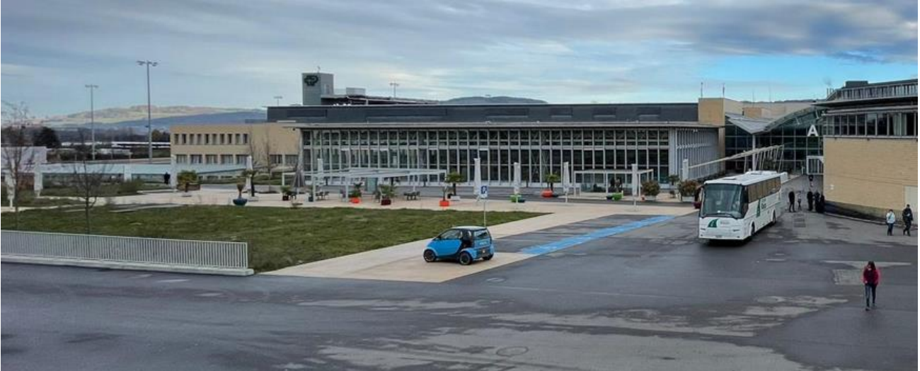
Abbildung 16: Komplett versiegelte Flächen vor dem Hauptgebäude
