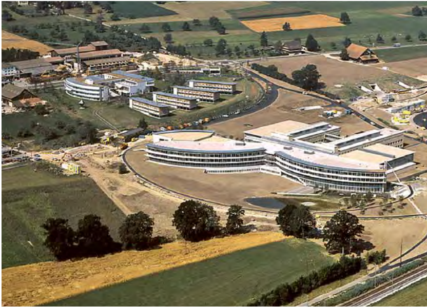
Pour des raisons de coût, la clinique ne comptait que deux étages au lieu des trois prévus.
